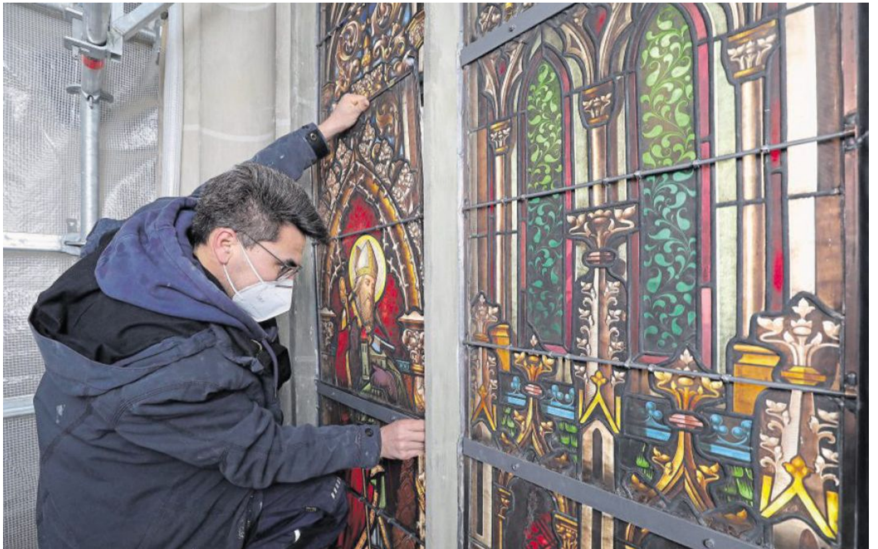
Gerade sind sechs Fenster von St. Martin in Paderborn restauriert worden. Jetzt werden sie vorsichtig wieder an ihre Plätze im Kirchenschiff gesetzt.
