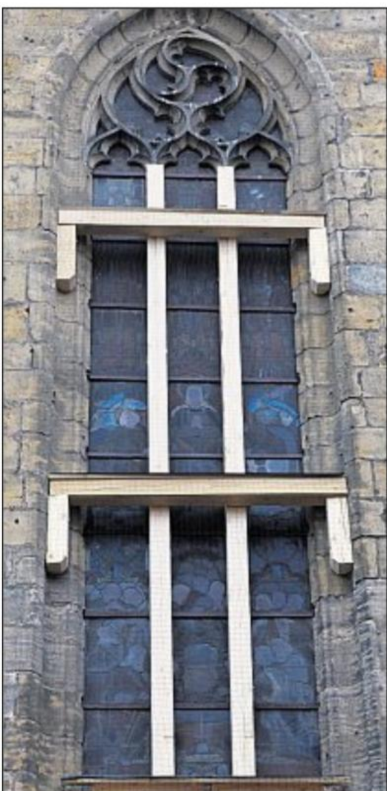
Die Fenster sind jetzt durch Fangnetze und Holzbalken gesichert.
